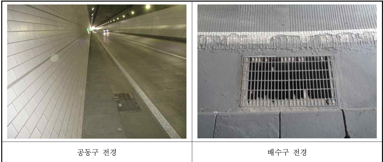
【사진 3.11】 공동구 및 측구(배수로) 전경
