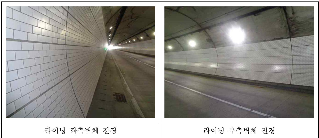
【사진 3.5】 터널 라이닝 측벽부 전경
