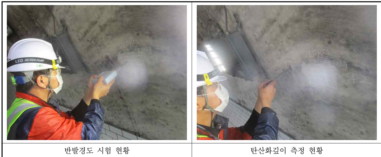
【사진 3.17】 콘크리트 내구성조사 현황
