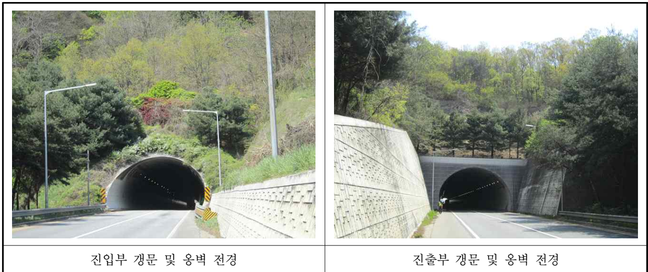
【사진 3.7】 갱문 진·출입부 전경
