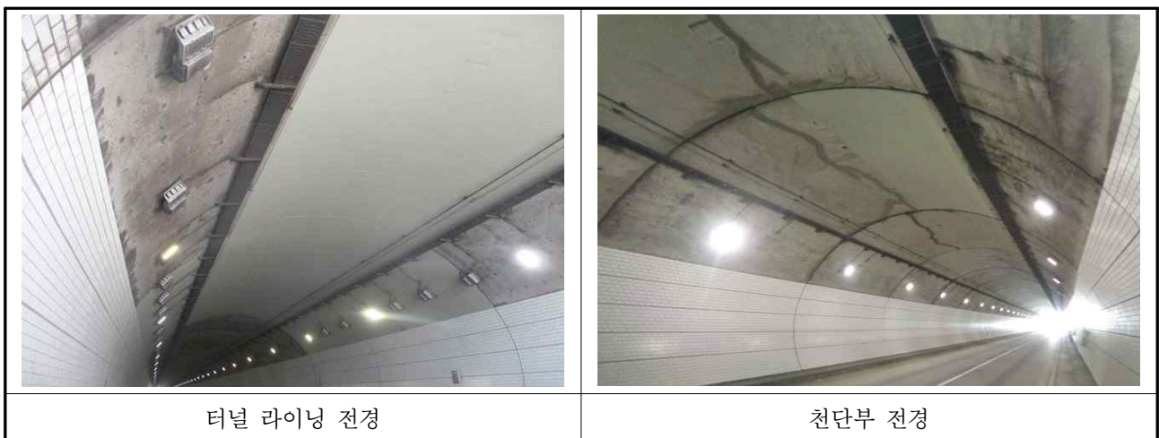
【사진 3.3】 터널 라이닝 천단부 전경
